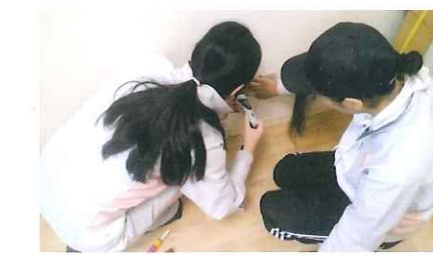
写真7)施工作业の様子
